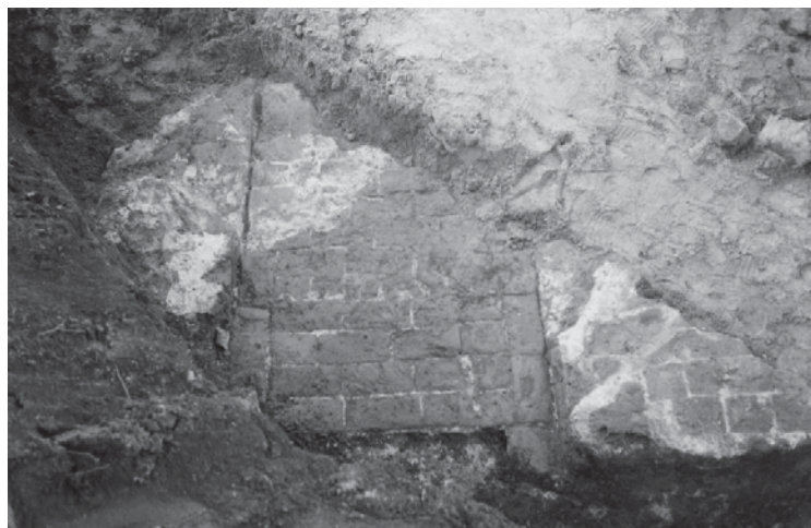
Afb. 10. Doorgang vanuit de noordoostelijke toren naar de binnenplaats. Aan de onderzijde van de foto de buitenmuur van de toren aan de binnenplaats. Foto auteur.
