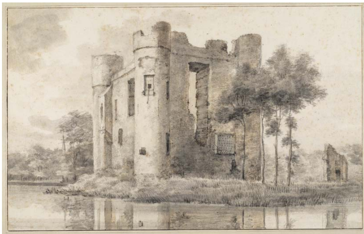
Abt. 3. De zuidwesthoek van het kasteel, zoals getekend door Roghman d.d. 1647. Zichtbaar zijn de uitkragingen op het bovenste niveau van de toren. Teylers Museum, Haarlem. Foto: RDMZ.
