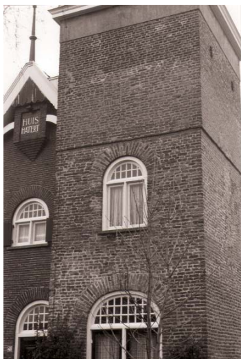
Afb. 11a en 11b. Aanzicht van de oostelijke torengewel (situatie in april 1995). 1: 19e-eeuwse verstoring van het oorspronkelijke metselwerk ten behoeve van de deur- en raamopening. 3: Restant van een dichtgezet venster of moordgat met ter plaatse van de onderdorpel een rollaag. 4: Uitkragende muizenand, waarvan de uit het vlak van de muur springende baksteenkoppen zijn afgekap. 6: 19e-eeuwse ophoging van de toren. Tezamen met de kap in 1969/1970 sterk gerestaureerd. 8: Onregelmatige horizontale baan in het metselwerk. Datering en functie onbekend. De nrs. 2, 5 en 7 zijn onbelangrijke sporen. Foto en tekening: auteur.
