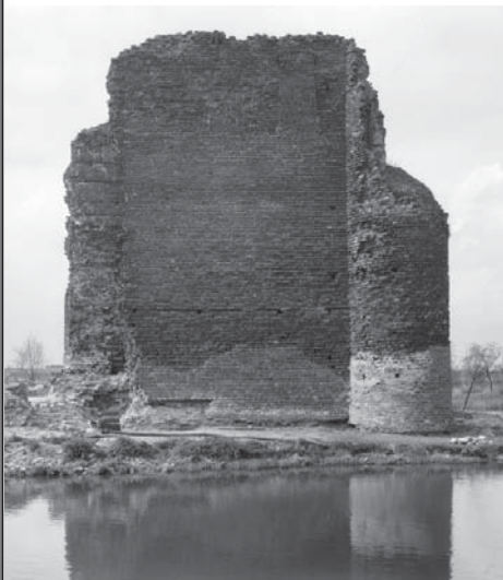
Afb. 11. Foto van de noordgevel vlak voor de restauratie in de jaren '60 van de twintigste eeuw. In de noordgevel zijn op de verdieping twee dichtzettingen zichtbaar, de meest oostelijke is het voormalige rookgat van de haard op de begane grond. De westelijke dichtzetting is die van het oorspronkelijke venster. Foto: RDMZ.
