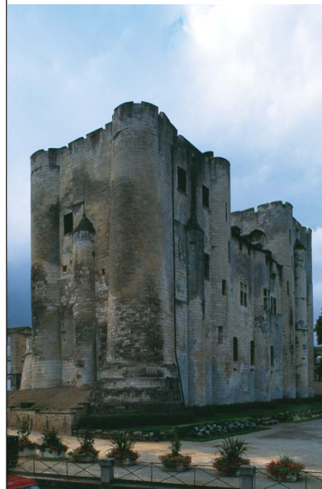
Afb. 25. Niort uit het derde kwart van de 12e eeuw is één van de eerste residentiële torens met ronde hoektorens (Deux-Sèvres). De gevels zijn nog voorzien van steunberen. Foto L.J. Smals.
