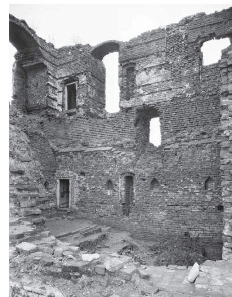
Afb. 12. Foto van de westwand vlak voor de restauratie in de jaren '60. In de westwand is de meegemetselde aanzet van het tongewelf van de begane grond zichtbaar. Op de verdieping is op de zuidwesthoek de oorspronkelijke doorgang naar de torenkamer bewaard gebleven. Aan de overzijde, op de noordwesthoek is de dagkant van de doorgang naar de noordwesttoren nog zichtbaar. Deze is tijdens de restauratie van de jaren '60 verdwenen. Ten zuiden van de doorgang is het restant van het oorspronkelijke venster met instapnis zichtbaar in de vorm van een dichtzetting. Op begane grond en verdieping zijn de openingen tot de putschacht bewaard gebleven. Foto: RDMZ.
