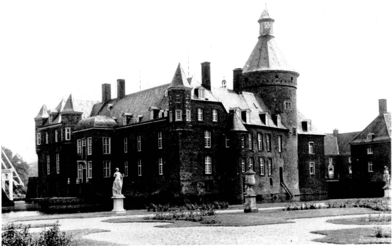
Slot Anholt gezien vanuit het noordwesten.
