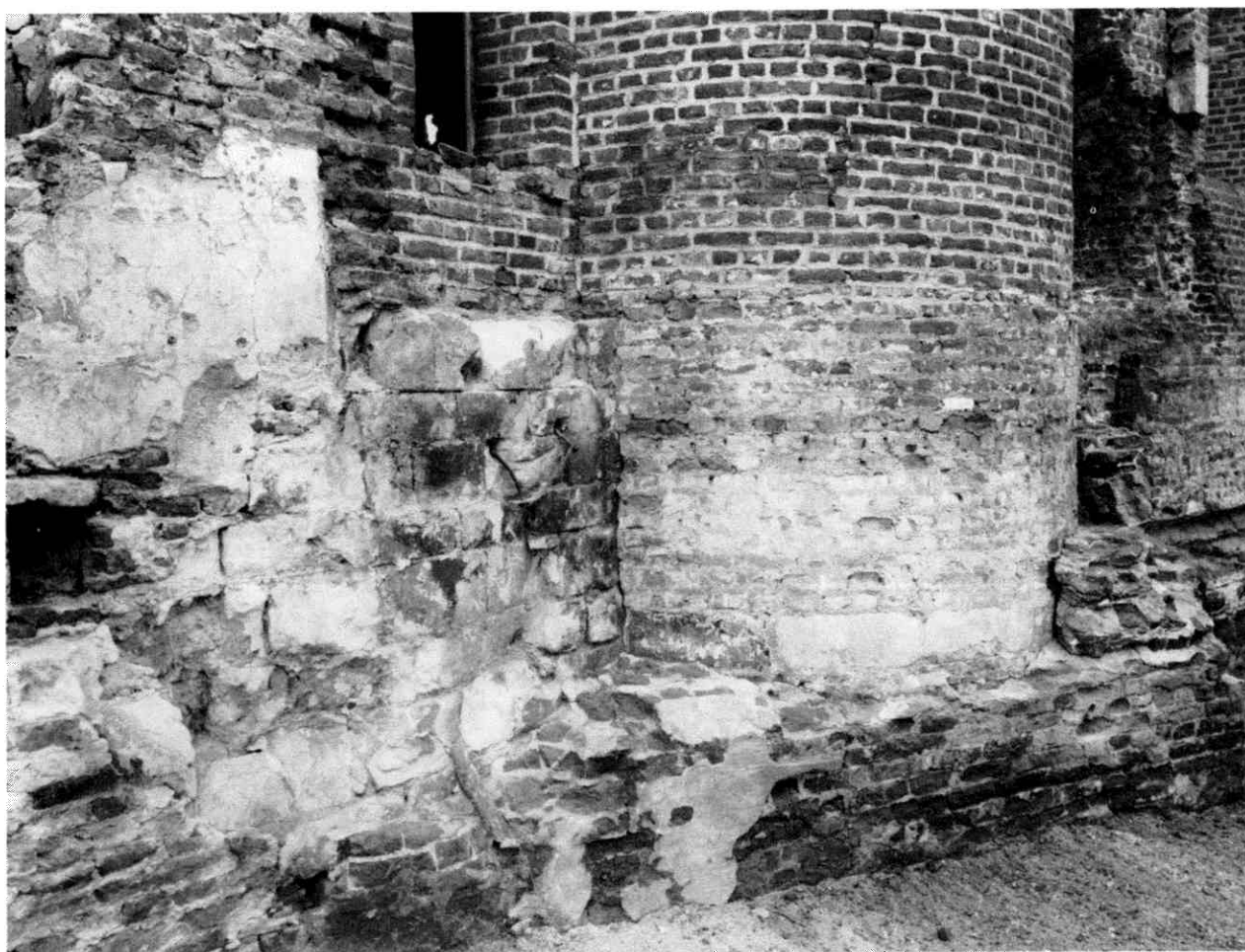
Afb. 13 In de bouwwallen van Geysteren na de verwoesting van 1945. Links de zaalwand uit mergelblokken. De voet van het traptorentje uit baksteen staat los van de zaalwand (Foto auteur).
