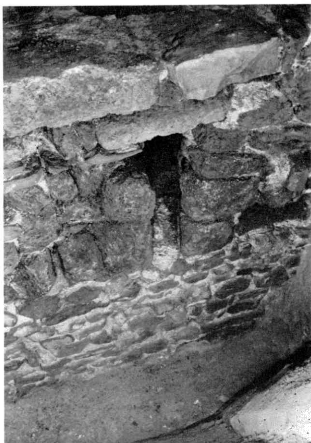
Afb.6 Gedeelte van de oostwand van de oudste woontoren, met lichtspleet.
