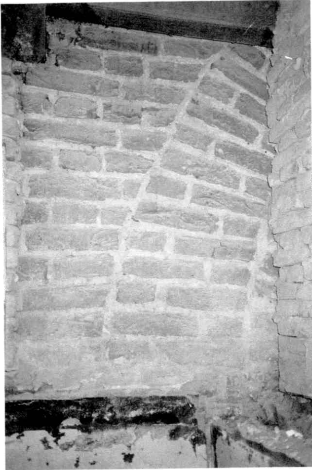
Afb. 3. Linker aanzet van de poort doorgang, bedon weggebouwd en afgedekt door voorgezette nieuwe buitenmuur.
