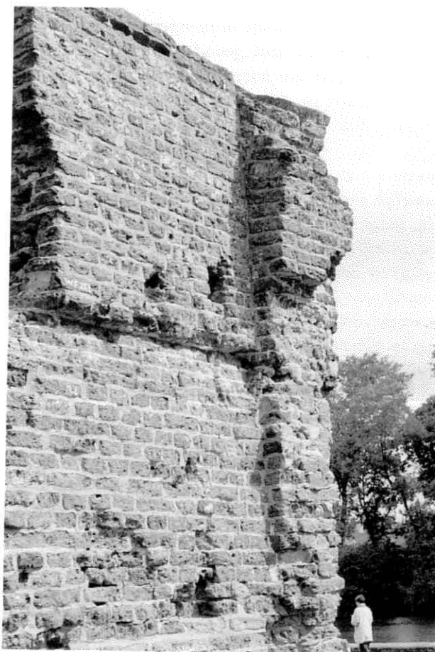
Afb. 5 Binnenkant van de Rentmeesterstoren met aanzet (boven, rechts) van de boog. Foto E. Cordfunke
