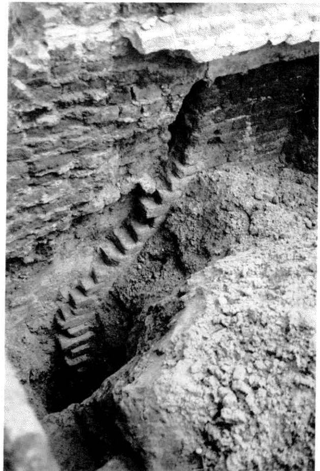
Afb. 5. De vallende tand in de fundering van de zuidwesthoek van de woontoren (foto M. Tillema)
