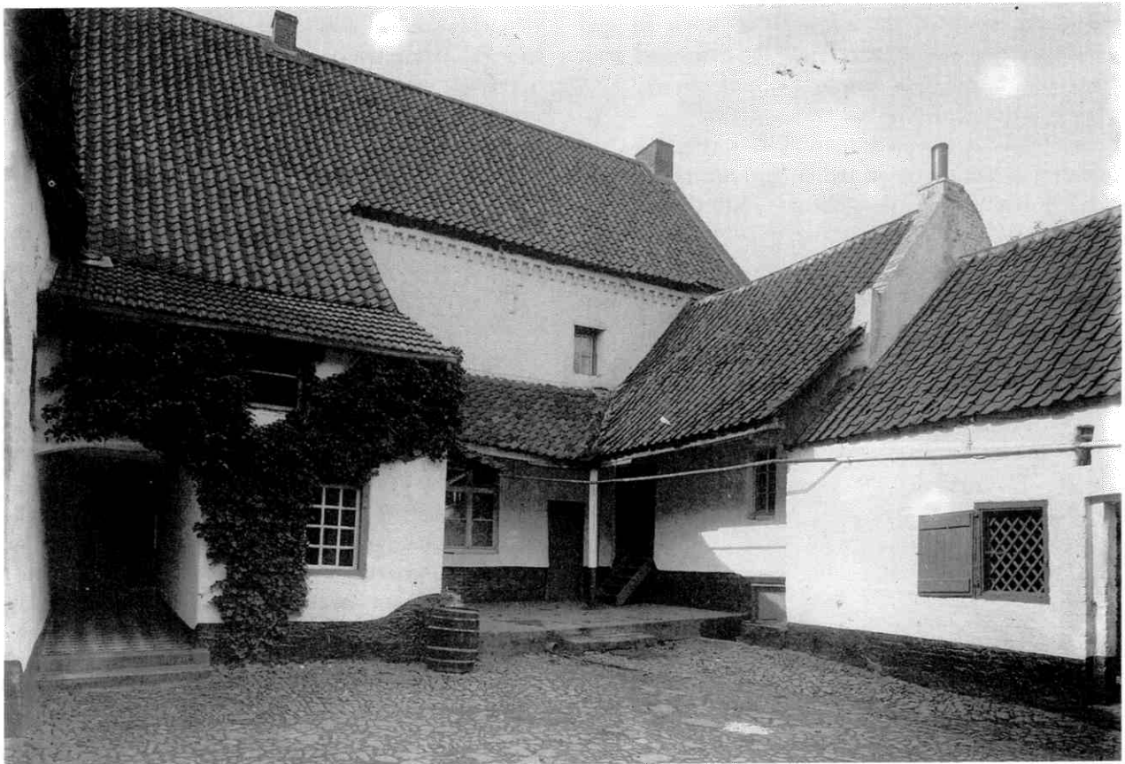
Afb. 12. De binnenplaats gezien naar het zuidwesten, 1996. Het rechter gedeelte is na de brand van 1937 vernieuwd, daarbij is de nok verlaagd. Op de plaats waar de oorspronkelijke nok aansloot op de noordgevel van de woonvleugel is een kleine sprong in de tandlijst te zien.
