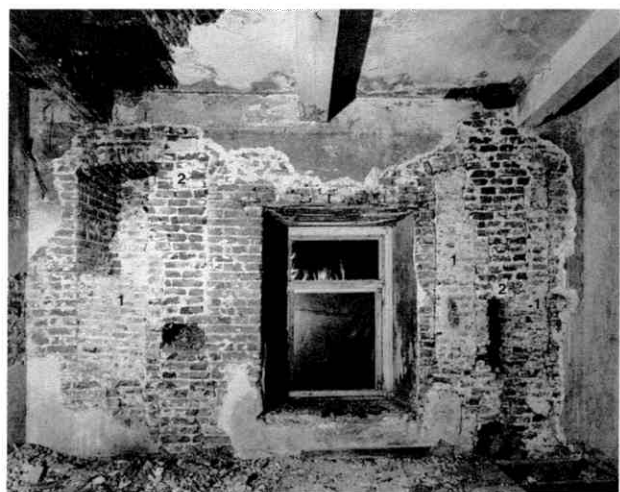
Afb. 17. Verdieping van het poortgebouw met de dichtgezette vensters (1) en sleuven voor de ophaalbrug (2).
