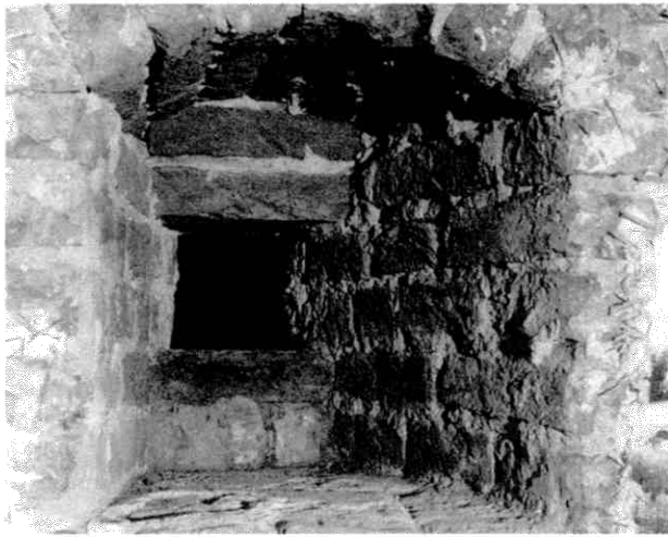
Afb. 18. Verdieping van het poortgebouw, het schietgat aan de zijde van het binnenplein met het houten bakje onderin.
