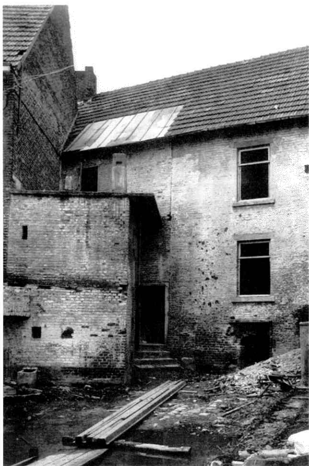
Afb. 10. De poortdoorgang aan de binnenpleinzijde in 1983.
