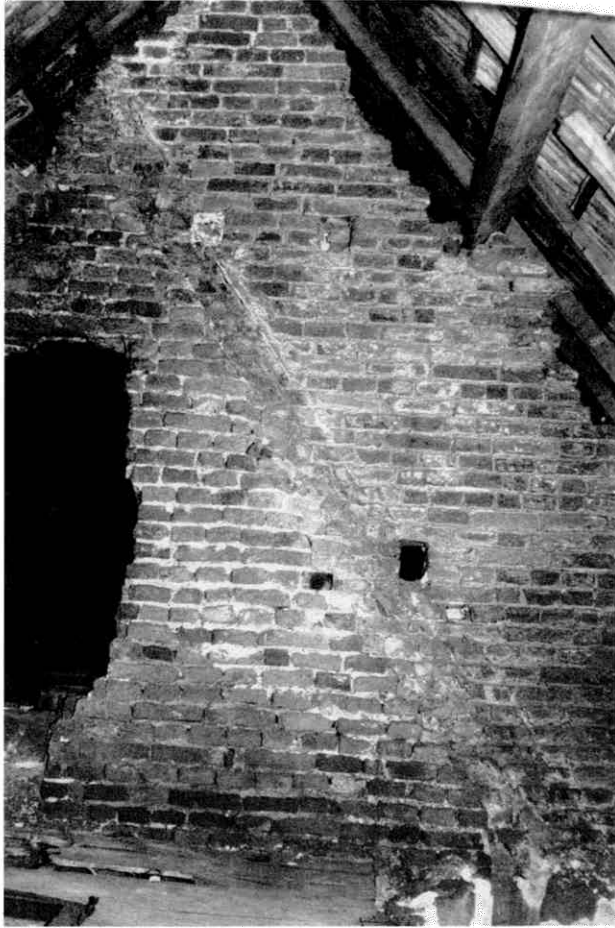
Afb. 21. Oostelijke poort-zijwand, aftekening van de lagere aankapping van de poortaanbouw.
