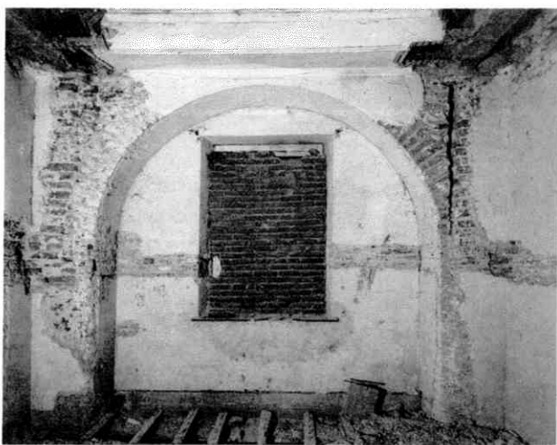
Afb. 14. Interieur van het poortgebouw, gezien naar het zuiden; rechtsboven de gleuf van de brugketting.
