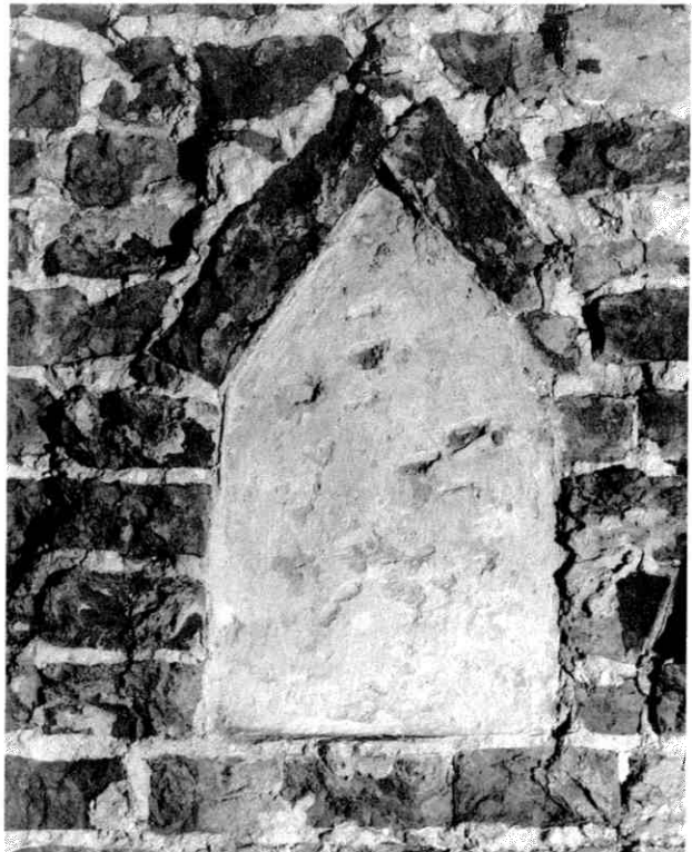
Afb. 20. Het kaars- of lampnisje in de poort-zijwand.
