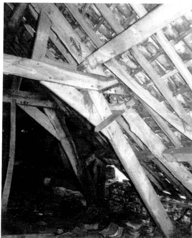
Afb. 27 Telmerken op de spantdelen in de stalvleugel.
