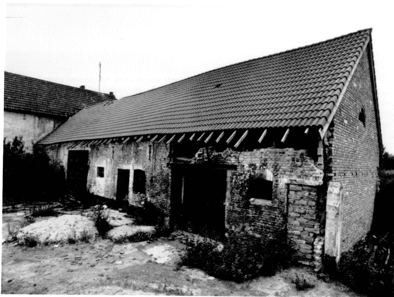
Afb. 28 De ingekorte stalvleugel met de nieuwe eindmuur (1988)
