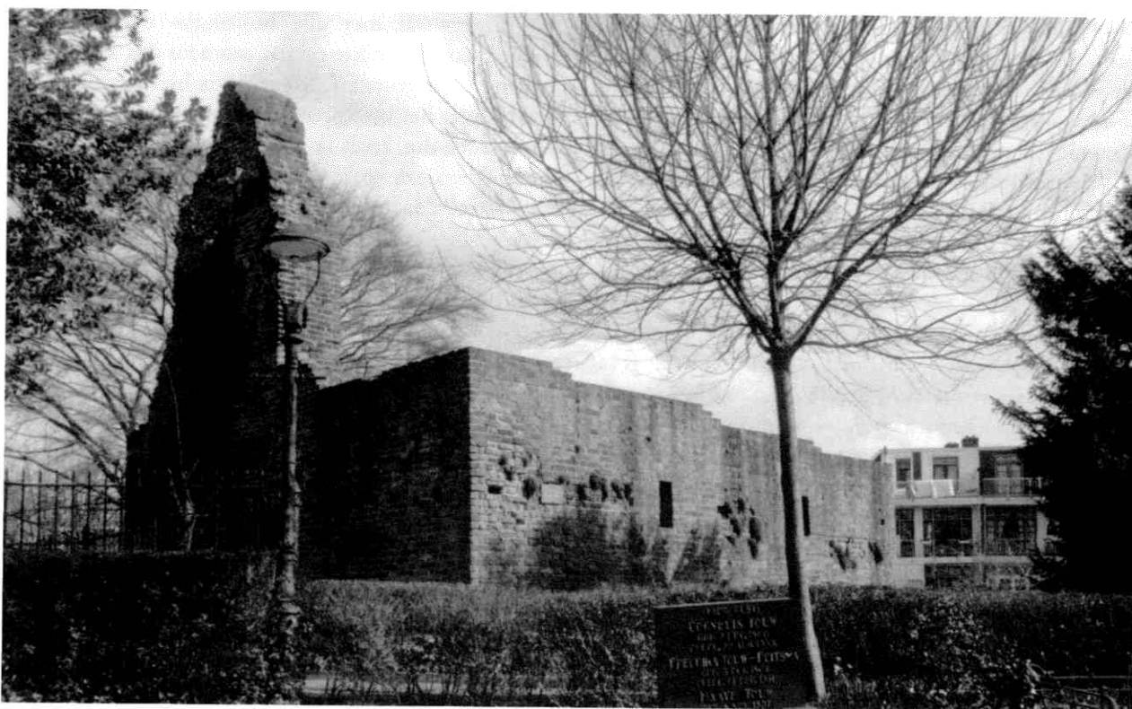
Afb. 11 Restanten van de woontoren te Hillegersberg, gezien vanuit het zuiden (foto auteur).
