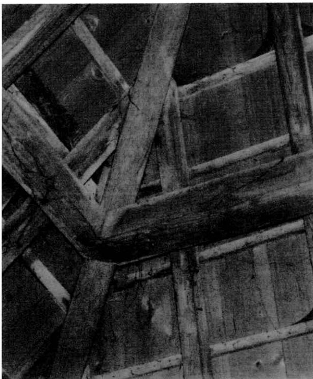
Afb. 7 Verlengde fliering in de kap van de westelijke vleugel van Huis te Warmond (grachtzijde). Fliering van eikenhout, verlenging in grenen (foto auteur).
