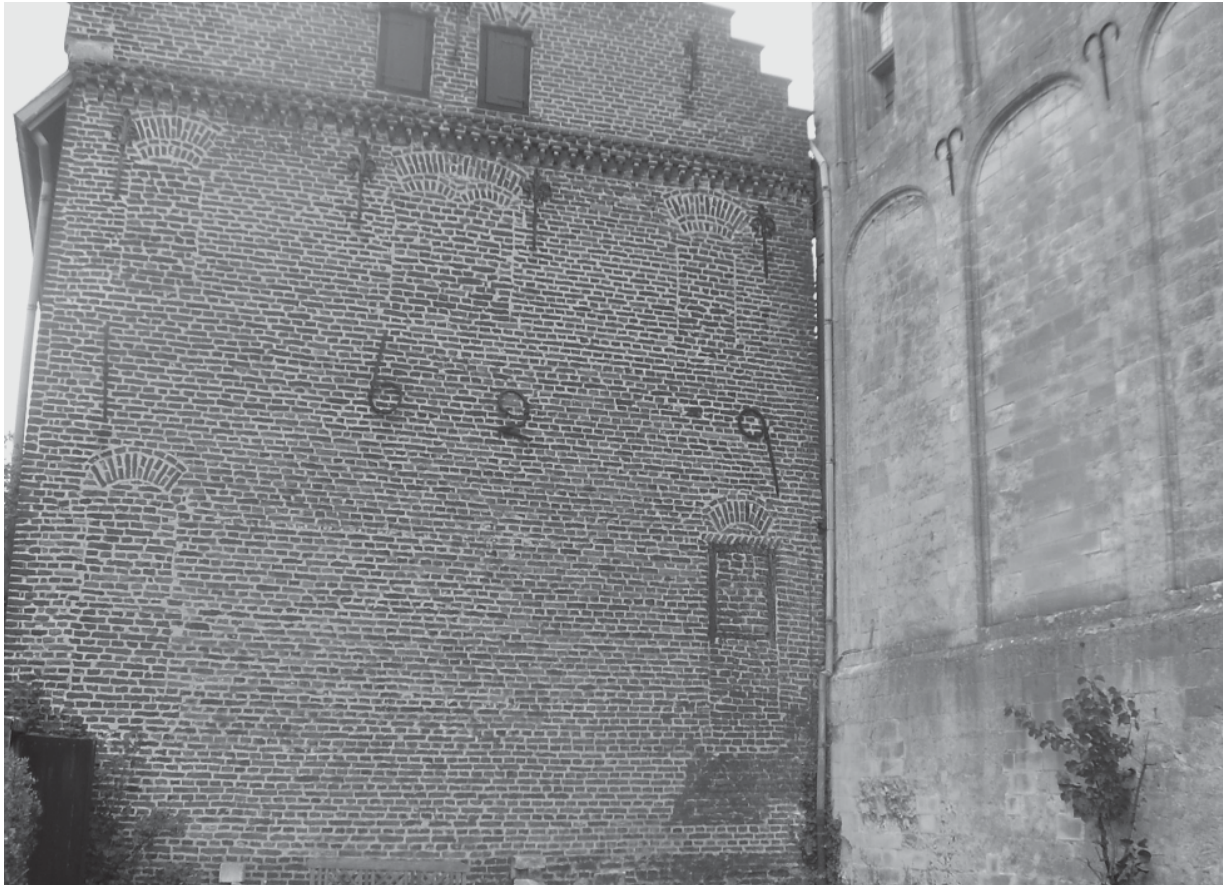
Afb. 2. Het Geudje, met muurankers in de vorm van het jaartal 1629. Foto: H. Ronnes.
